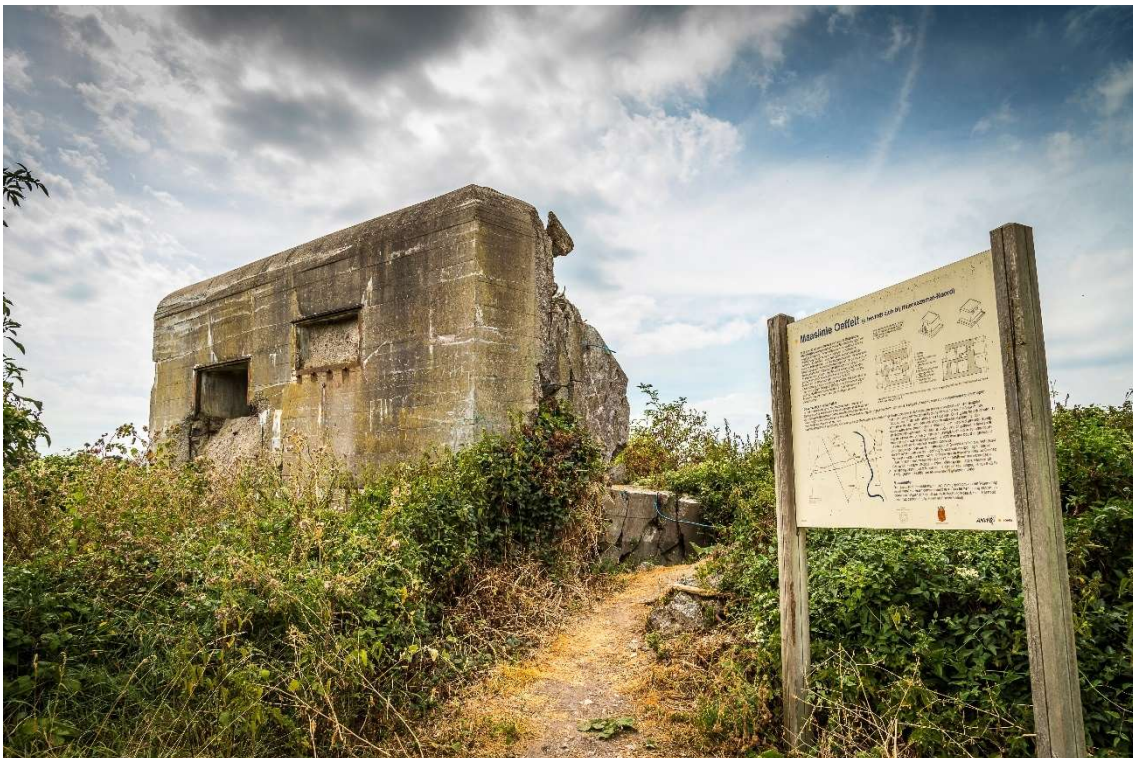
Figuur 3 Een van de kazematten in het projectgebied, ten noorden van de Maasbrug (WSP, 2021)
