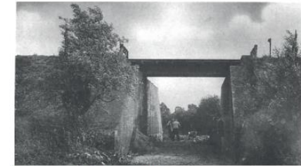
Brug in het talud van het Duits Lijntje
